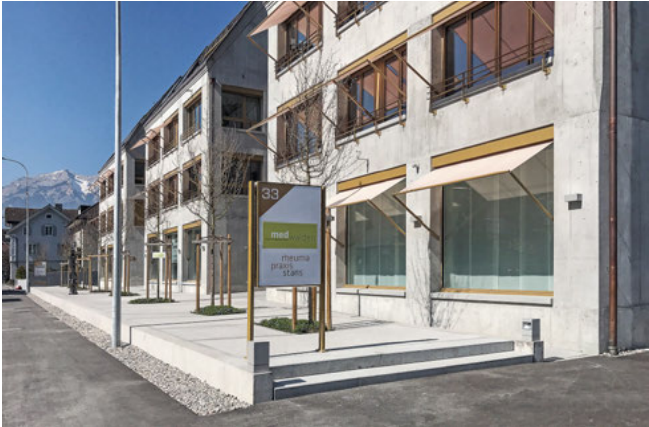
Objektschutz an einer neuen Überbauung im Zentrum von Stans NW: Die erhöhte Kante des Vorplatzes und die offenen Zufahrten am Gebäude vorbei leiten allfälliges Hochwasser in den hinteren Bereich und verhindern das Einströmen in die Untergeschosse. Architektur: plus architekten, Stans.
