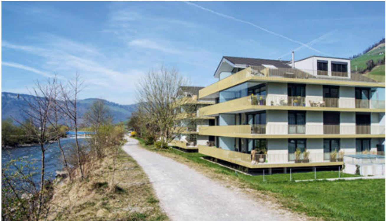
Haus auf Stelzen in Büren/Oberdorf NW: Der bauliche Objektschutz an dieser Immobilie an der Engelberger Aa stellt sicher, dass das Hochwasser nicht ins Gebäude eindringt, ungehindert abfliessen kann und nicht auf die Nachbarparzellen seitlich abgeleitet wird. Architektur: Kontur Architekten, Stans.
